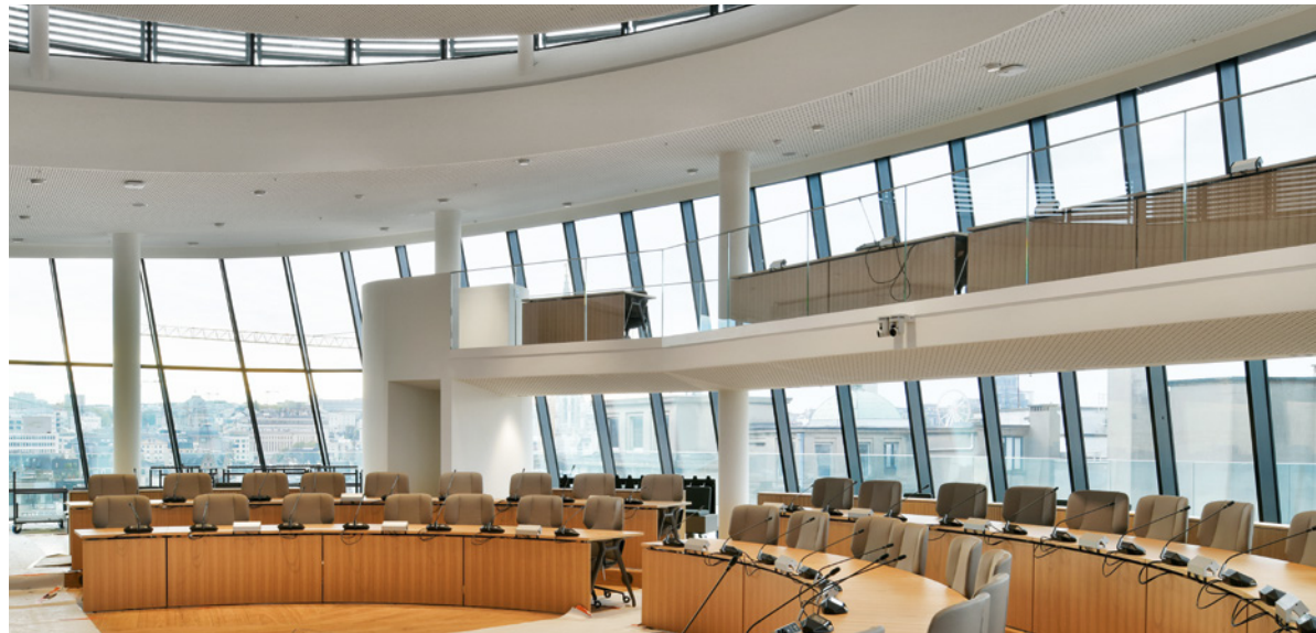
Brüsseler Stadtverwaltungszentrum Brucity mit der Schüco Stahlaufsatzkonstruktion AOC 60 ST. Foto: © Serge Brisson
