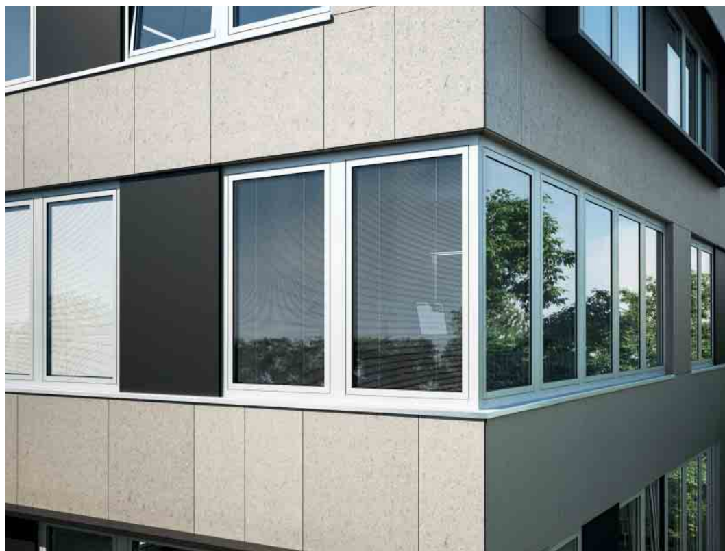
Verbundfenster auf Passivhausniveau Composite window to passive house standard
