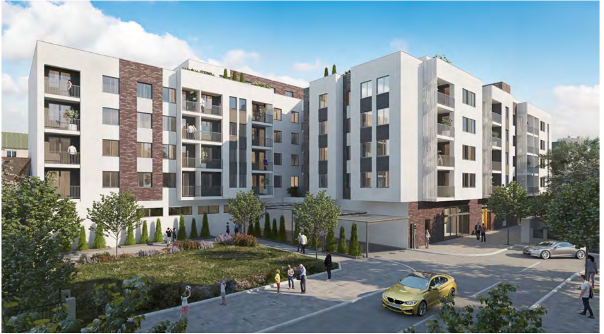
Stambeno-poslovni kompleks Emerald Garden Residence
